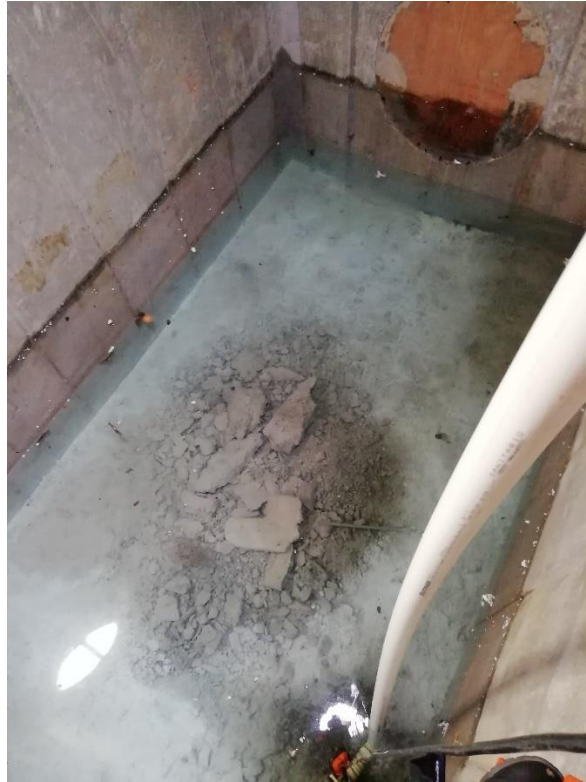
Fotografía 5: Vista del interior del pozo 25-60A, coordenadas 209472 N/526031E
