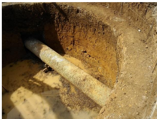
Fotografía 6: Material de tipo limo-arenoso aflorando en el punto de perforación ASE-97, coordenadas 209564 N/525875 E.
