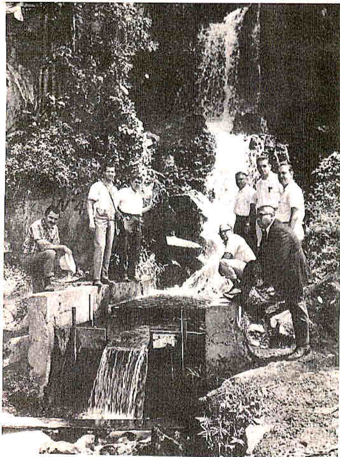
Directores, Subgerente e ingenieros del SNA de visita en las fuentes de Puente de Mulas; el grupo aparece al pie de uno de los manantiales cuya producción será traída al área metropolitana.
