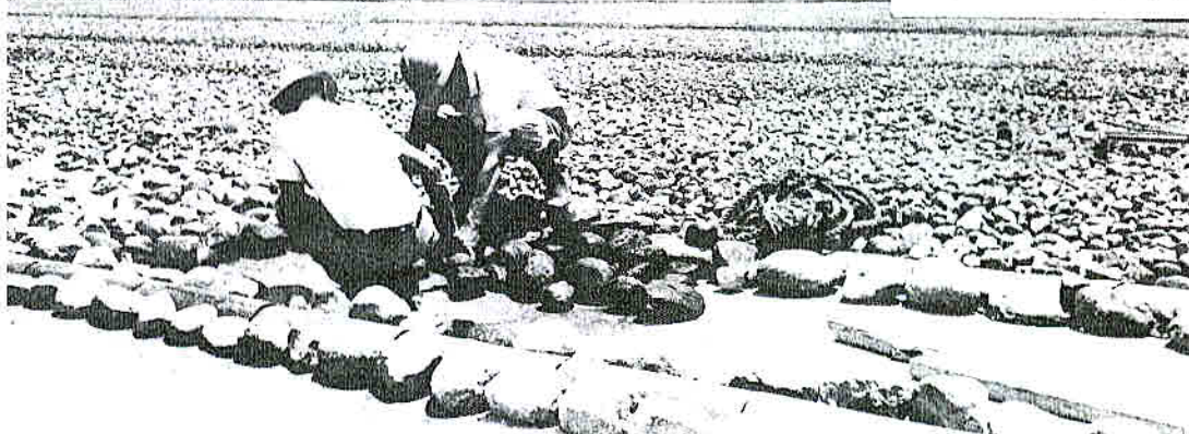
Limpieza de un filtro lento en las plantas de Tres Ríos.
