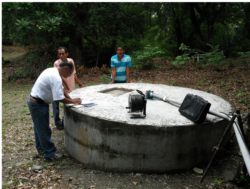
Foto 2. Pozo 2 (Coordenadas 349928 E / 243706 N)
