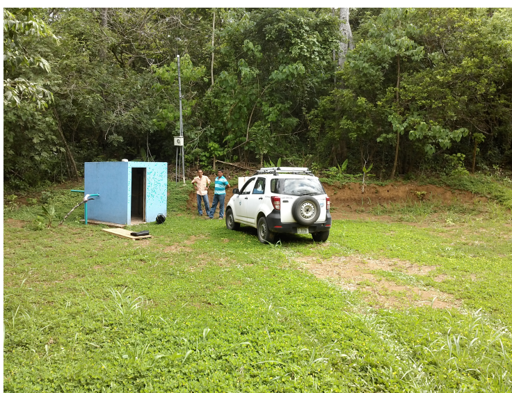
Foto 1. Pozo 1 (Coordenadas 350015 E / 243303 N).
