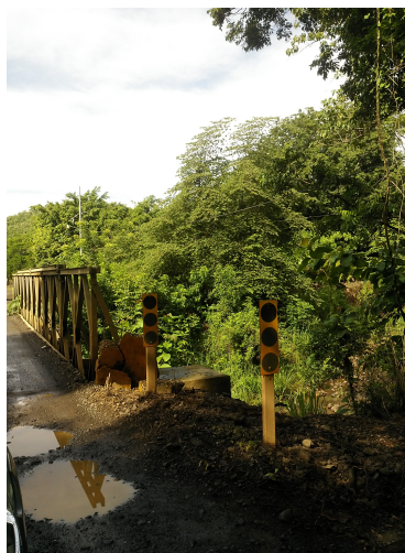
Figura 10. Puente sobre la quebrada Mono, a la salida de San Jorge. Coordenadas: 400271 E / 201758 N
