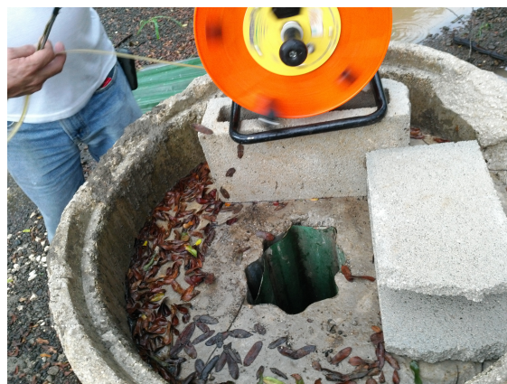
Detalle del brocal del pozo
