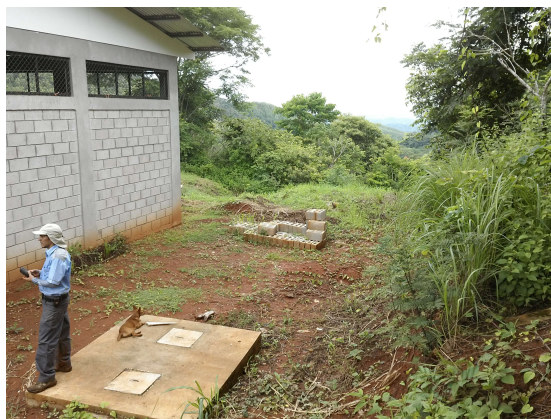
Foto 18: Futuro tanque de almacenamiento
