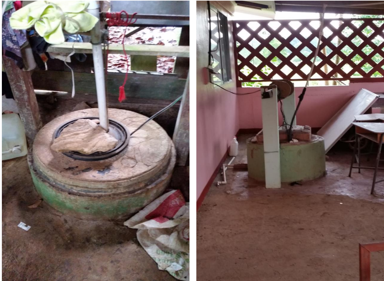
Fotografía 1: Vista de los pozos PACR - 1 (izquierda, coordenadas 318,446 Norte y 499,605 Este) y PACR - 3 (derecha, coordenadas 318,486 Norte y 499,739 Este).
