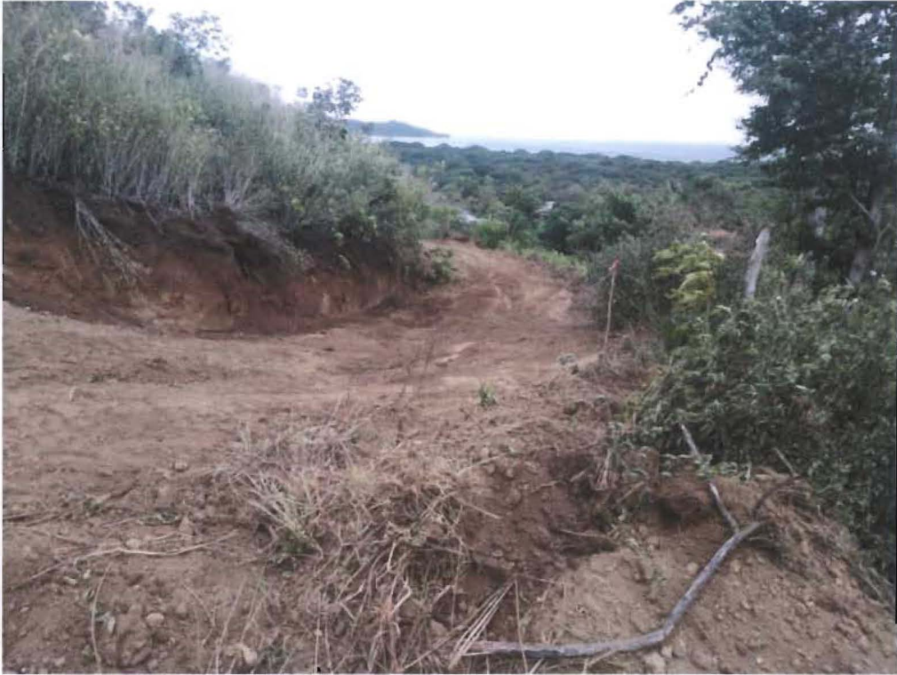
Anexo 14. Limpieza del terreno
