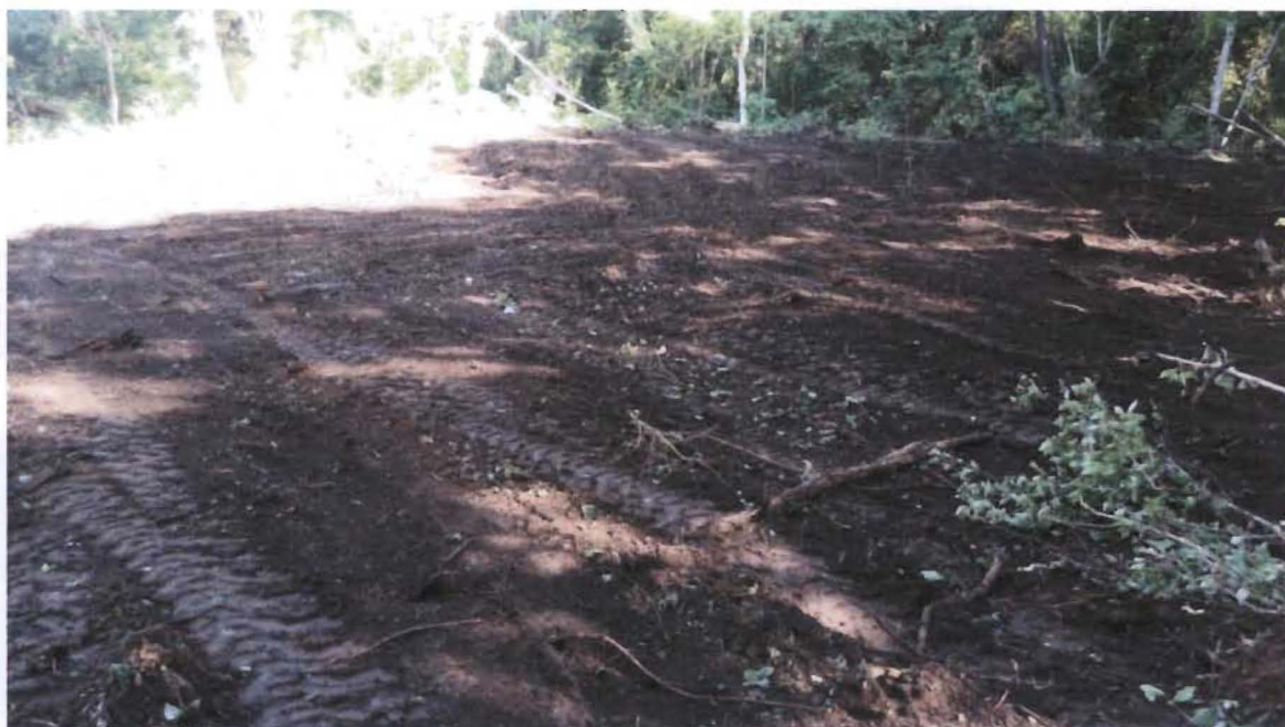
Anexo 5. Limpieza del terreno
