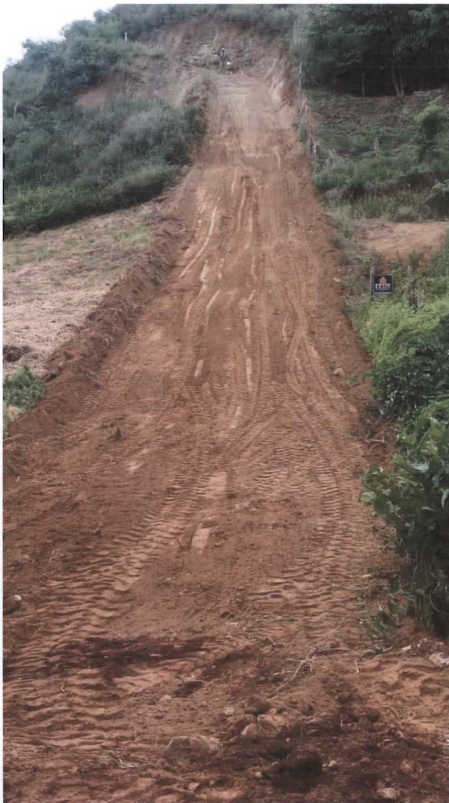
Anexo 15. Limpieza del terreno
