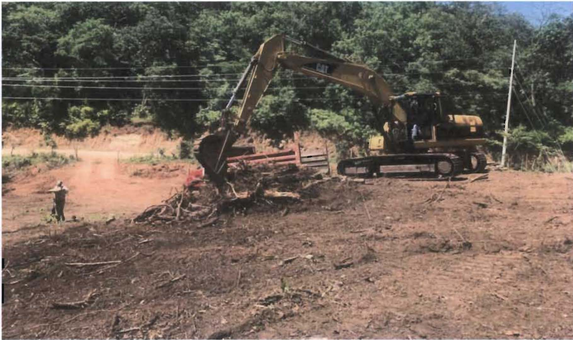
Anexo 8. Limpieza del terreno
